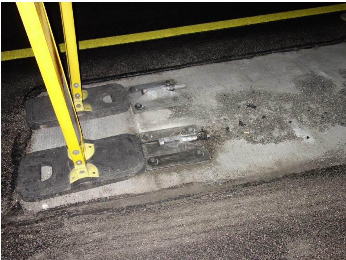
Verankerung im Frontbereich ok Seile abgerissen
