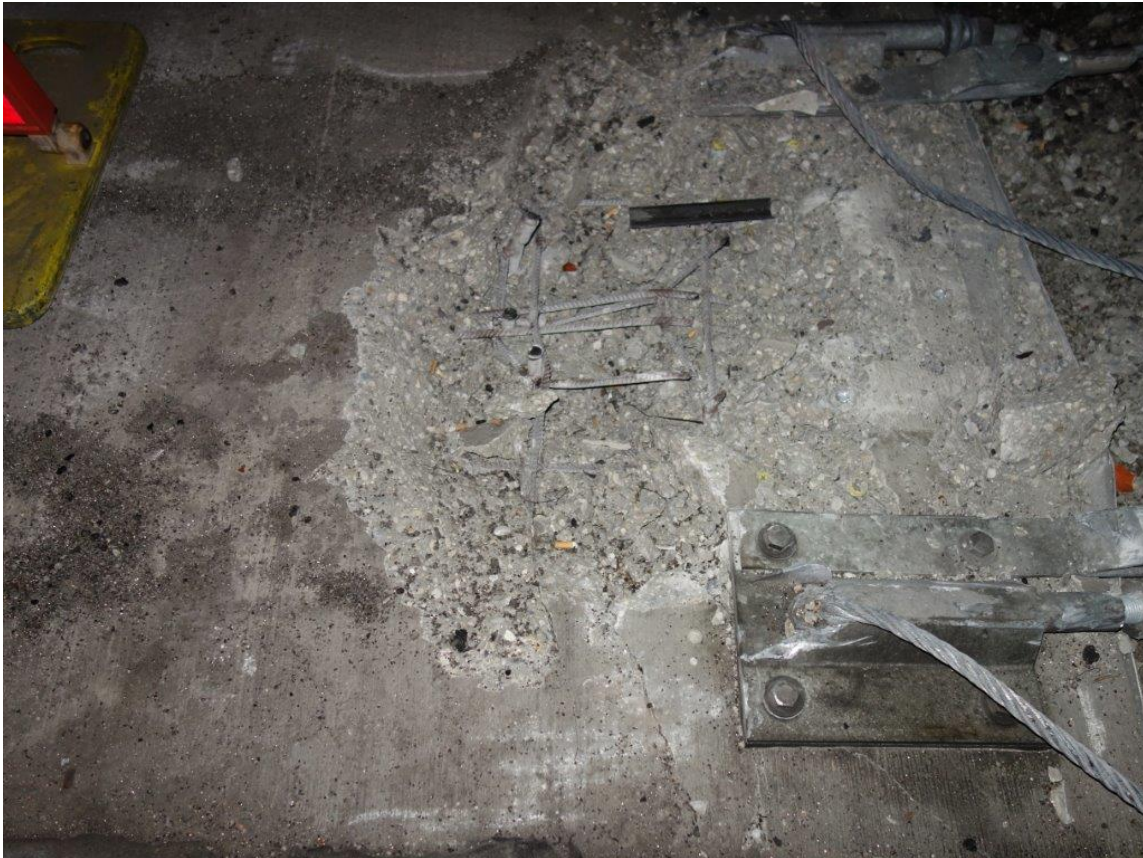
Verankerung im rückseitigen Bereich Ausgerissen
